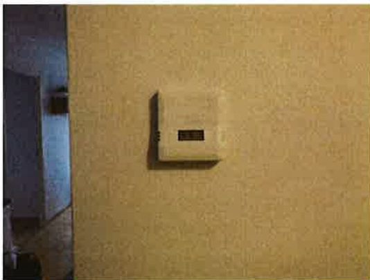
Asunnoissa lämpötilan ja suhteellisen kosteuden seuranta, jolla mm. säädellään lämmitystarvetta
