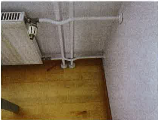
Pattereiden putkiläpiviennit
