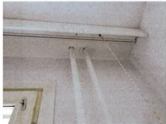
Pattereiden putkiläpiviennit
